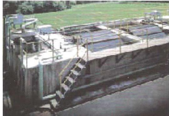
Kompaktanlage mit (2) STM – Zellräder zur Gülleaufbereitung bis zur Vorflutrerife, Japan
