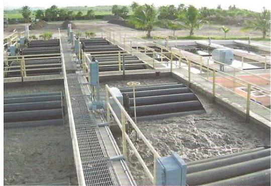
(9) Röhrenräder STM – RR 4,3 x 2,5 für 1. & 2. Ausbaustufe, Palmas del Mar Resort WWTP, Puerto Rico
