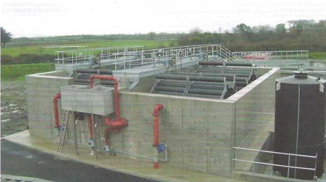
(4) Röhrenräder STM – RR 4,3 x 4,0 + 8A, weitergehende Abwasserreinigung mit Nähr- und Feststoff Eliminierung, Templemore WWTP, Irland
